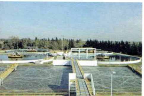
Ampliación de la Planta Depuradora Norte, de Aysa S.A.
