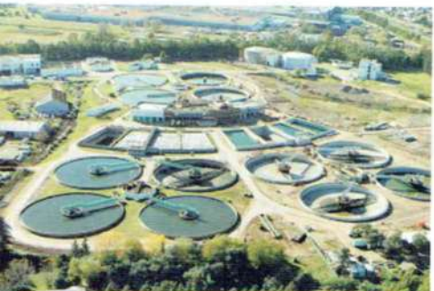
En la planta depuradora San Fernando, en la provincia de Buenos Aires, se tratan los líquidos cloacales antes de ser vertidos en el río Reconquista.
