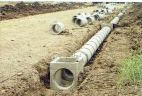
Una etapa en la construcción de una red cloacal.
