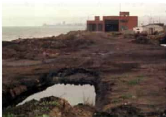
Planta de efluentes cloacales en Mar del Plata.
