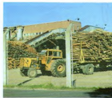
▲ Planta de Celulosa Argentina en Zárate, provincia de Buenos Aires.
