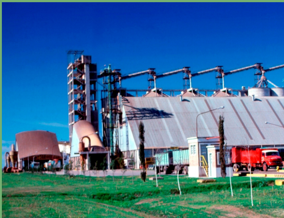
Las empresas multinacionales tienen una gran presencia en la Argentina. Planta de Cargill
