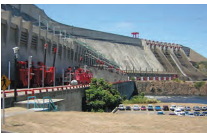
La represa Simón Bolívar (ex Guri) sobre el río Orinoco fue construida hacia la década de 1970 para abastecer la creciente demanda energética de Venezuela.
